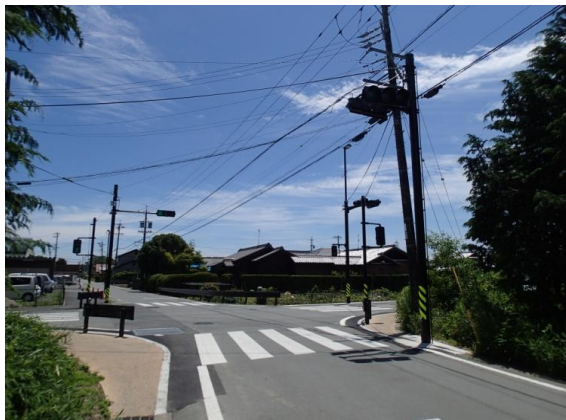
信号柱の改修
