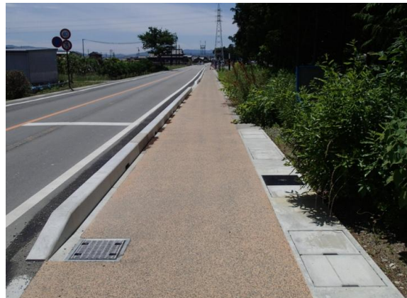
歩道整備状況
