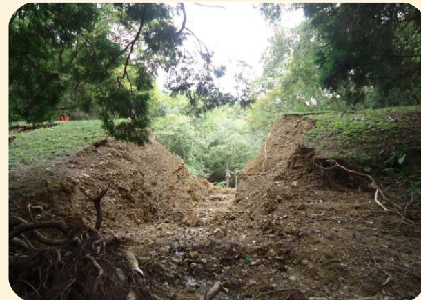
台風による大雨により決壊したため池
