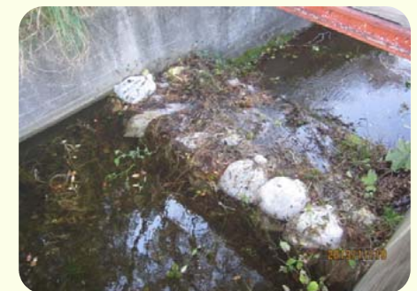
土のうによる洪水吐のかさ上げ
