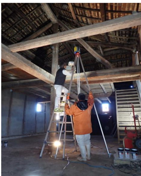
上村味噌蔵測量調査 12月24日
