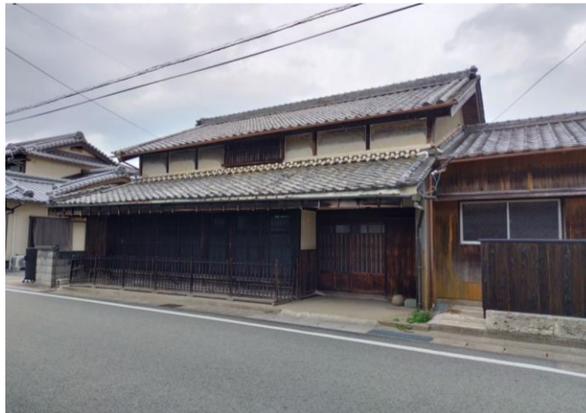
改修後の古民家(主に内部修景)
