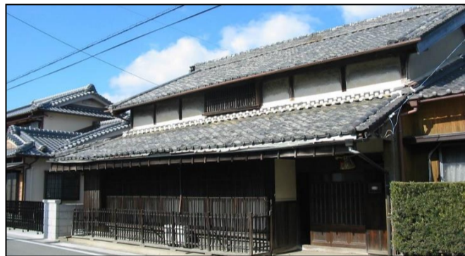
古民家 (改修前)
