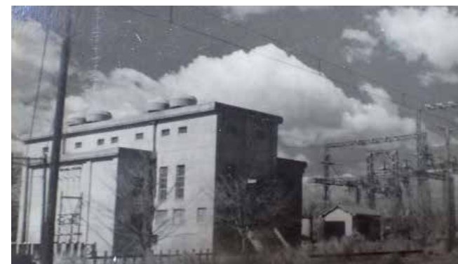
かつての南斎宮駅変電所（田所 信子氏提供）
