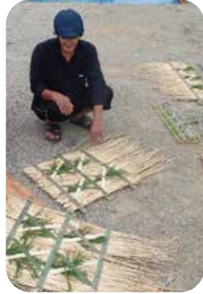
祠部分の壁製作
