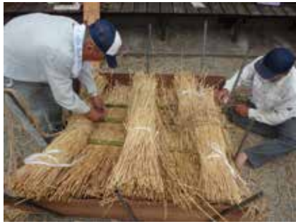
軒部分の 取付け
