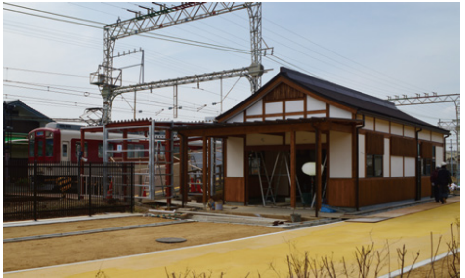
3月19日の完成に向けて工事が進んでいます。
