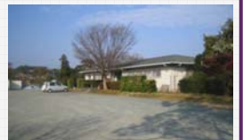
整備箇所の現状
