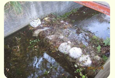
土のうによる洪水吐のかさ上げ
