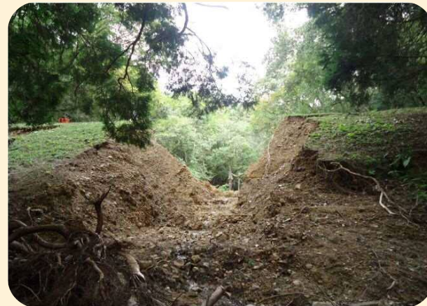
大雨により決壊したため池
