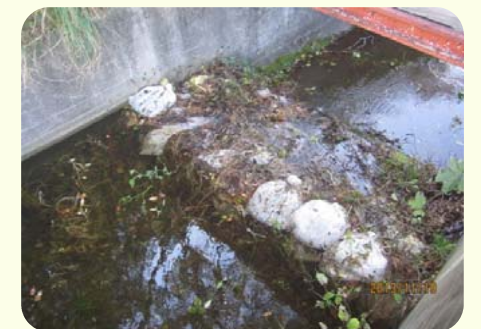
土のうによる洪水吐のかさ上げ
