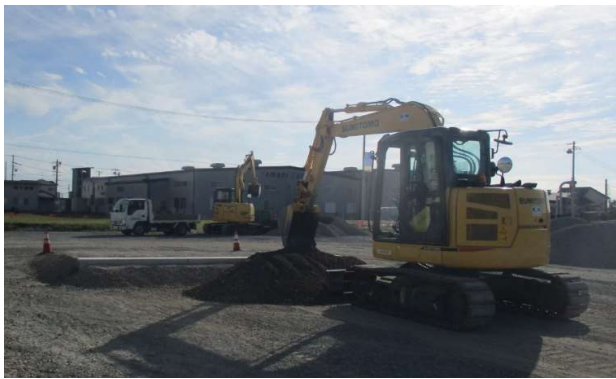
土砂敷均し状況
