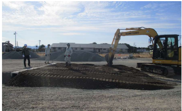
土砂敷均し完了
