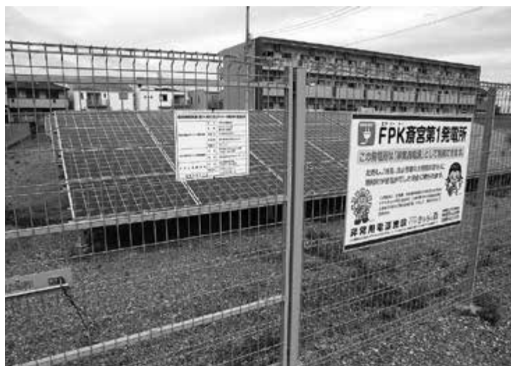
F P K 斎宮第1 発電所
