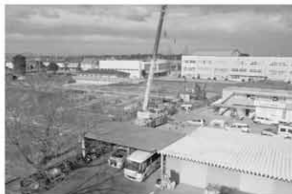
中学校建設現場（平成 30 年 12 月末）
