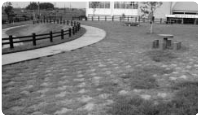
美化センター跡地整備
