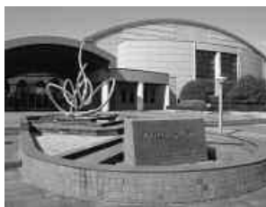
町総合体育館
