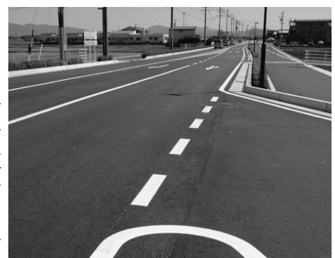
完成した明和中央線第4工区
