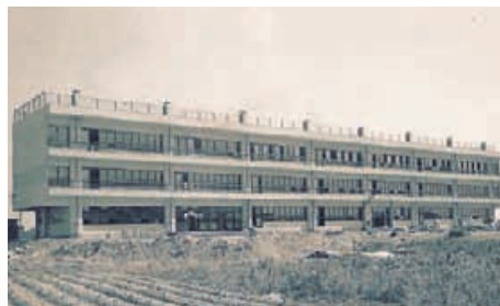
昭和39年5月に完成した大淀小学校の新校舎
