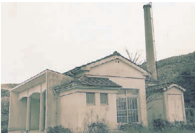
老朽化が進んだ菊狭間火葬場。昭和61年10月には、1市6町村共同出資による南勢広域斎場が完成
