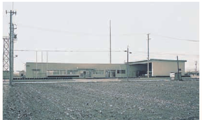
昭和60年2月、松阪地区広域消防組合明和分署が新築移転。敷地には訓練スペースを確保し、夜間照明も設置
