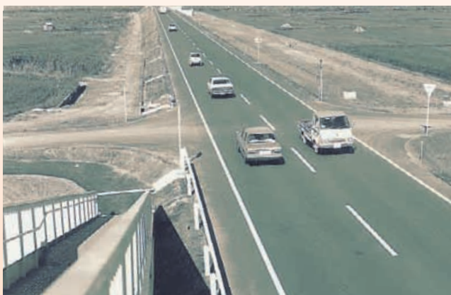
昭和50年10月、暫定2車線の南勢バイパス(国道23号)が全線開通
