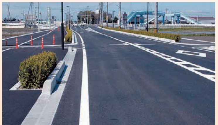
平成20年3月、国道23号交差点改良を含む町道明和中央線第4工区事業、2.7㍓の道路改良事業が完了
