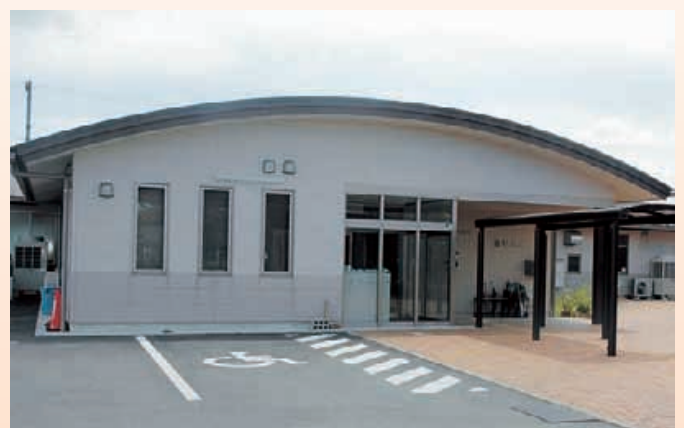
障がい者通所授産施設「ありんこ」が、平成17年3月に完成
