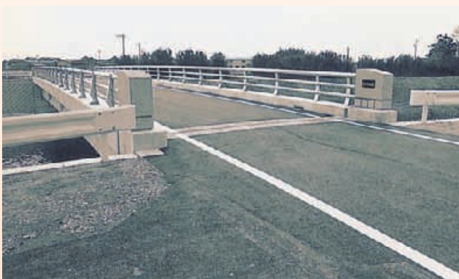
2カ年継続事業で行ってきた新川橋の架け替え工事が、平成元年3月に完了
