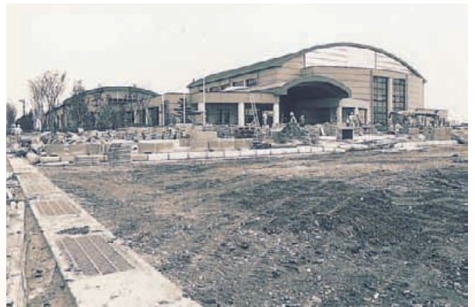
平成元年10月、総合体育館が完成し、記念講演や太鼓フェスティバルなどが行われた(写真は完成間近の総合体育館)
