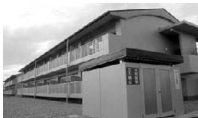
上御糸団地建て替え工事
