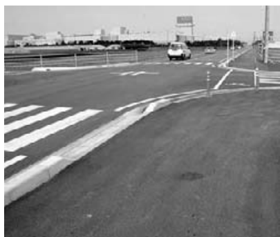
前野川尻線の自転車歩行者道・車道 工事
