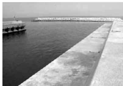
下御糸漁港の沖防波堤設置工事
