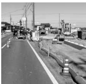
工事が進む前野・川尻線自歩道整備工事
