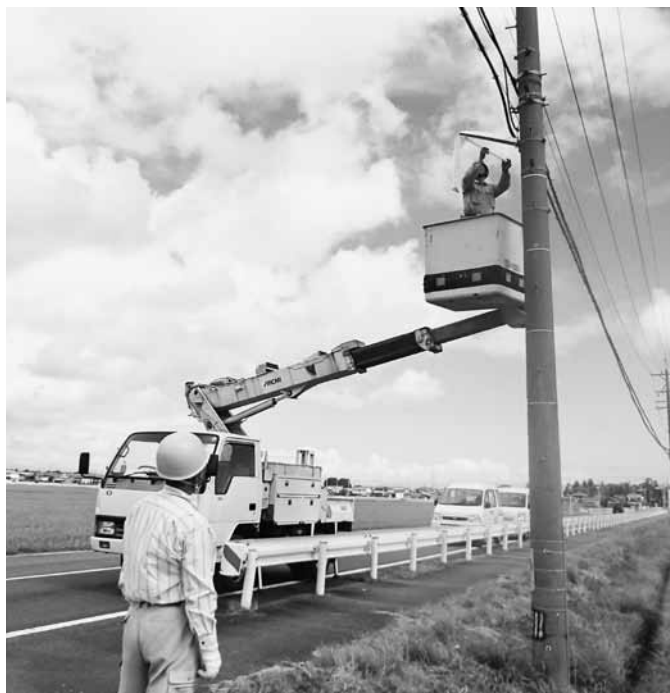
防犯灯の点検作業を行っていただきました
