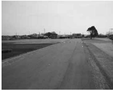
史跡齋宮跡東部整備現場
