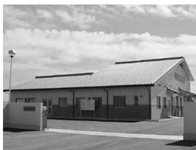
完成した笹笛処理場
