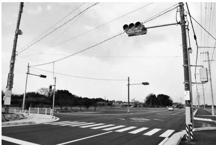
設置された信号機（佐田地内）
