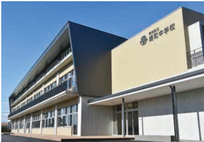
完成した新校舎
